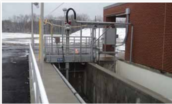
Se pueden instalar raspadores y/o bombas en los puentes para la remoción de arena.
