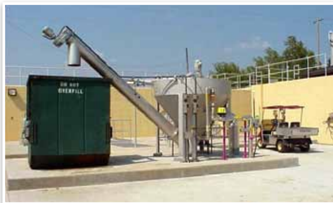
Lavador de arena para una arena excepcionalmente limpia y seca.
